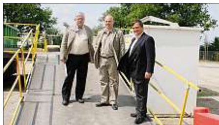
INNOVATION. Treyve paysage s'est doté d'une déchetterie mobile qu'elle déploie, ici, sur son site ou bien sur ses chantiers pour le tri systématique des déchets.
